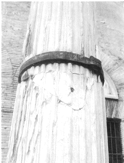
Photo 4 – Portico degli Dei Consenti . Detail of restored column shaft.
